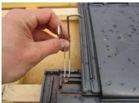
La finition parfaite des ouvrages est assurée par une large gamme d'accessoires adaptés comme le crochet anti-tempête. Le crochet de pannetonnage *Erlus Universal II* est une agrafe en acier inoxydable, résistant à la corrosion et simple à mettre en œuvre.
