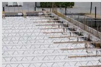
Avec un Psi de 0.60 pour un plancher intermédiaire de 20 cm, la prédalle Béton Armé à correcteurs de ponts thermiques intégrés a été conçue pour garantir le respect du garde-fou réglementaire de pont thermique périphérique en plancher intermédiaire.
